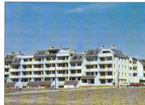
Wohnanlage in St. Veit / Glan - mit SW-span-Holzbetonmantelsteinen gebaut.
