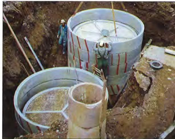
SW Bodenkörperfilteranlage beim Einbau.
